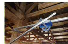
レバー式手動開閉装置
